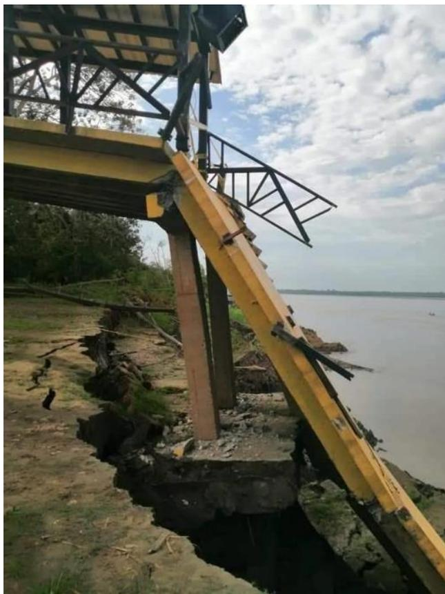
Ilustración 76. Muelle Fluvial del Municipio de Puerto Nariño destruido por la socavación del río Amazonas
